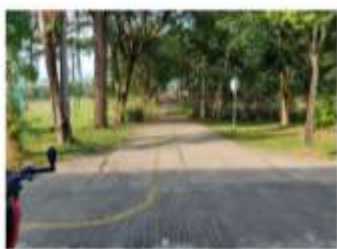
ถนน/รางระบายน้ำ ถนนคอนกรีต ปีที่สร้าง 2558
